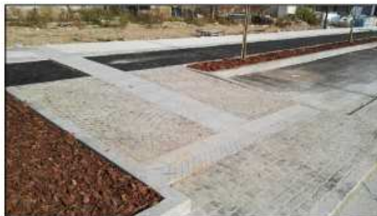
foto materiale - ribassamenti percorsi pedonali in cubetti di porfido posati a coda di rondine e piastre LVE per indicazioni disabili visivi (foto OOU 1°stralcio)
